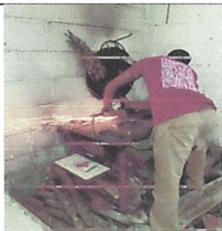
Foto1: Cortando la plancha de la estufa para tomar las medidas, para elaborar una nueva con las mismas medidas y características.
