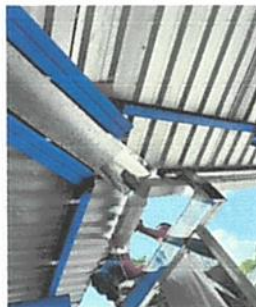
Foto 6: reparación de láminas y canales dañadas y colocación de la armadura con costanera previo a colocar las láminas del techo.
