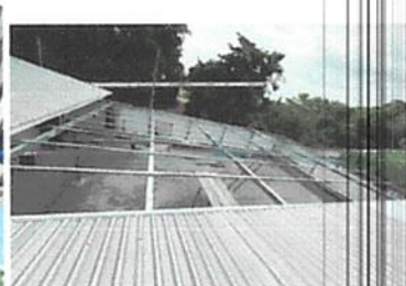
Foto 6: reparación de láminas y canales dañadas y colocación de la armadura con costanera previo a colocar las láminas del techo.
